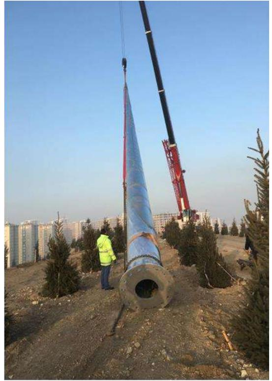
**Рисунок 4.4.10-Монтаж на фундамент**
